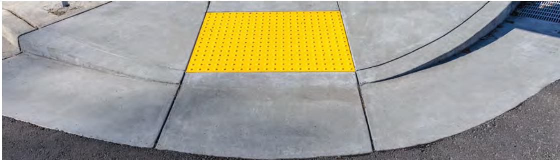
ADA Curb Ramp
